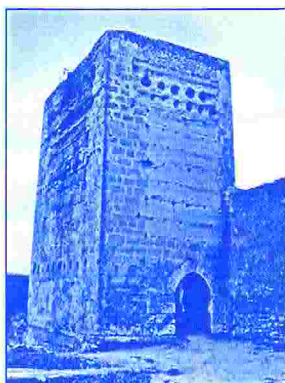
Torre almohade en la fortaleza de Alcalá de Guadaira
